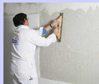
Træk Remmers klæbemørtel SLP på hele fladen med en tandspartel
