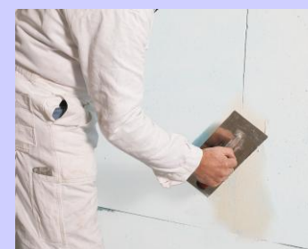
Spartling af pladesamlingerne med Remmers Skimmel-saneringspartel eller Skimmel-saneringspartel fin
